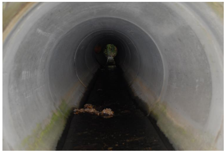
Durchlass des Entengrabens (Betonrohr, ohne trockene Berme)
